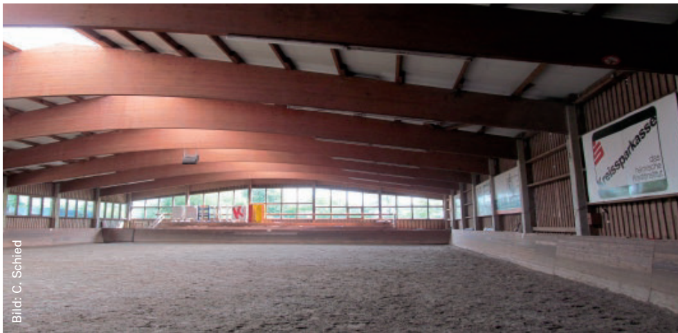
Der Einbau von LED-Leuchten in der Reithalle bringt helles Licht bei niedrigem Verbrauch.
