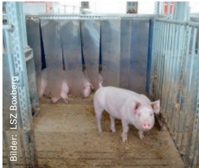
Bild 1 Mastschweinestall in alternativer Bauweise mit Teilspaltenboden sowie planbefestigtem Fress- und Liegebereich
