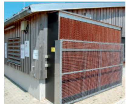
Bild 3 Geschlossenes und klimatisiertes Stallgebäude mit Kühlpad an einer Zuluftansaugöffnung
