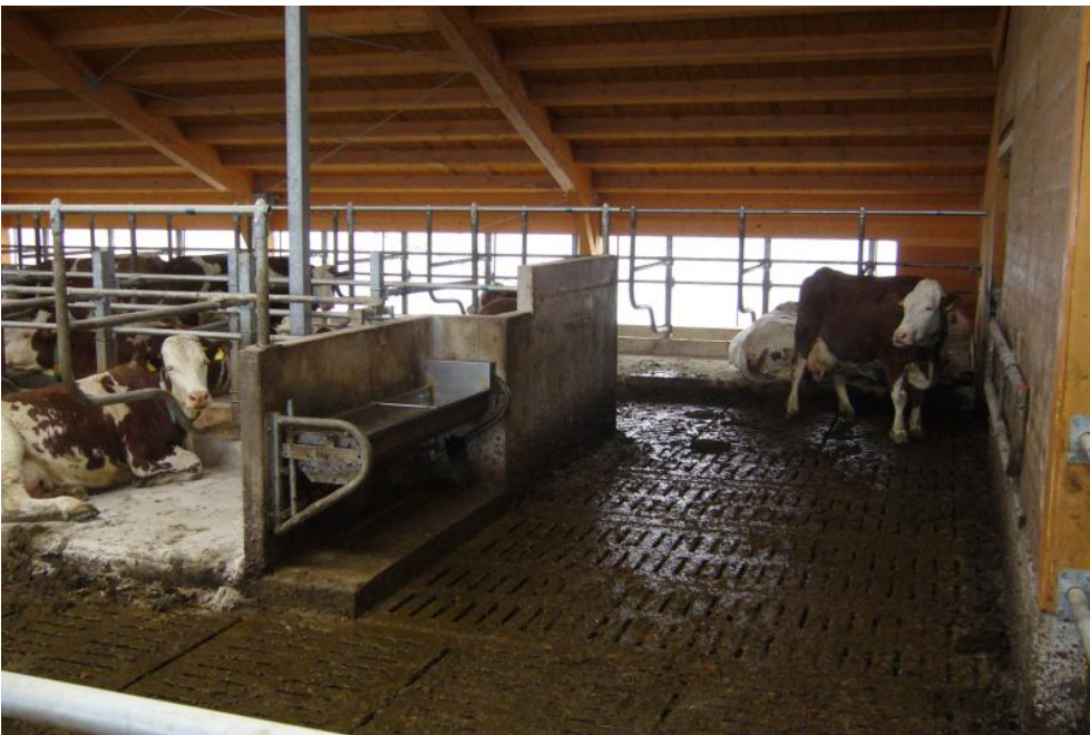
Foto 8: Zueinander versetzte gegenständige Liegeboxen sparen etwas Kopfraum, kommen dem Tierverhalten entgegen und bieten einen Platz für eine Tränke oder Viehputzbürste im Durchgang an. Allerdings fehlt die Fluchtmöglichkeit durch die Liegebox.
