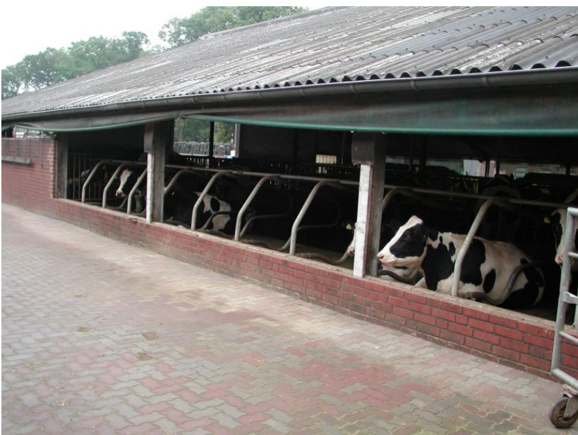
Foto 1: Das Entfernen von Außenwänden kann wandständige Boxen im verfügbaren Kopf-
