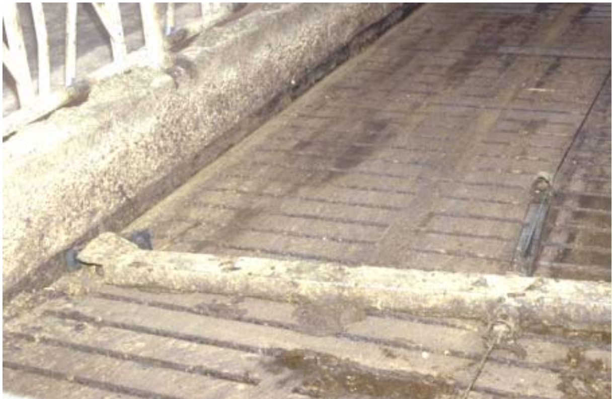
Abb. 4: Stationäre Einrichtungen zur Reinigung von Spaltenböden können die Klauengesundheit in Laufställen deutlich verbessern (Foto: Sekul)
